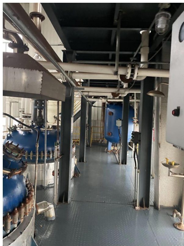
生产车间二层平台
