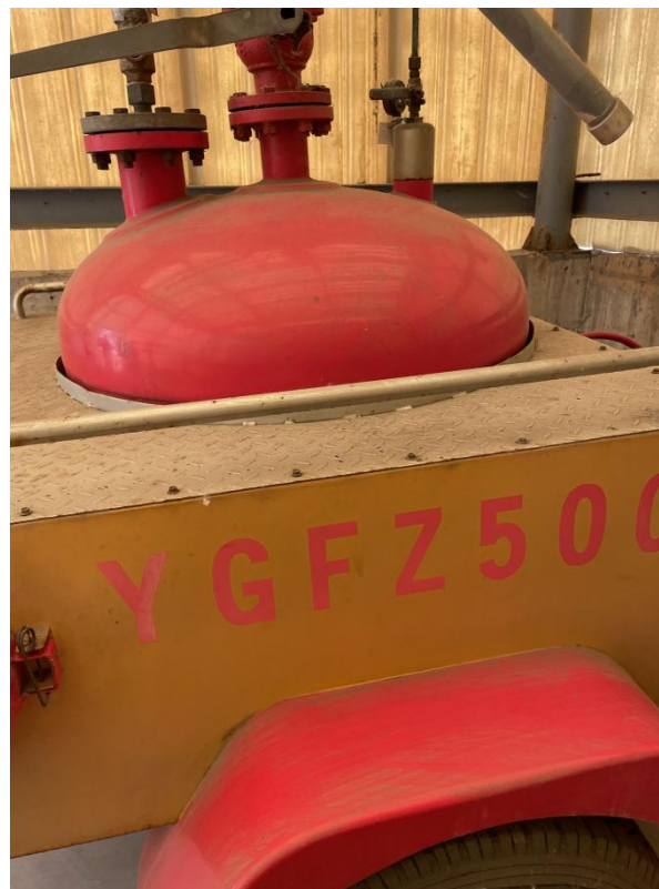
罐区干粉灭火装置
