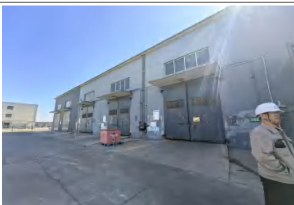
水处理剂罐区
